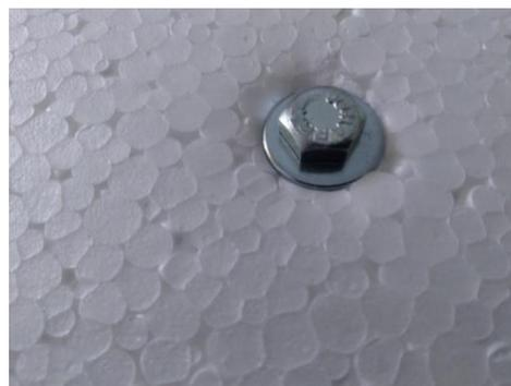
**Figura03.** Parafuso com arruela. Lado inferior do Telúrio.
